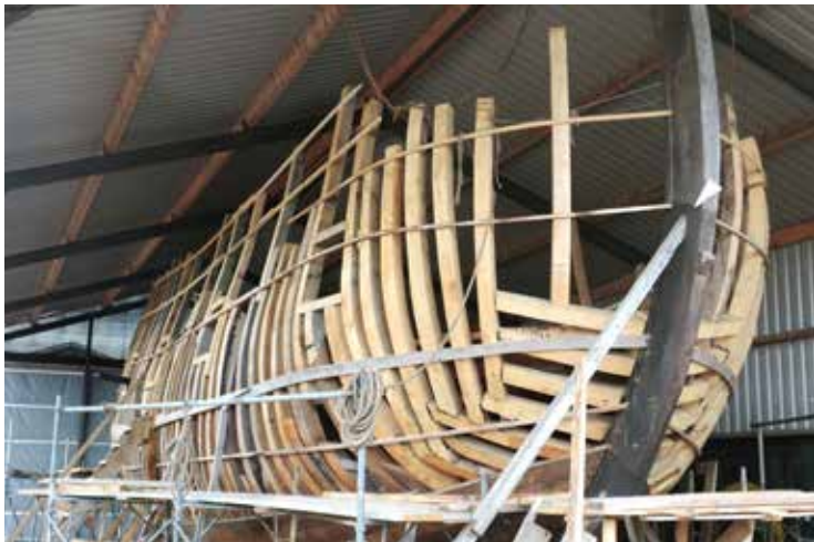
Met de onderschaal als basis werden de hogere spanten van de romp opgericht, in lijn gehouden door een aantal tijdelijke strooklatten. (Foto J. de Jager)
