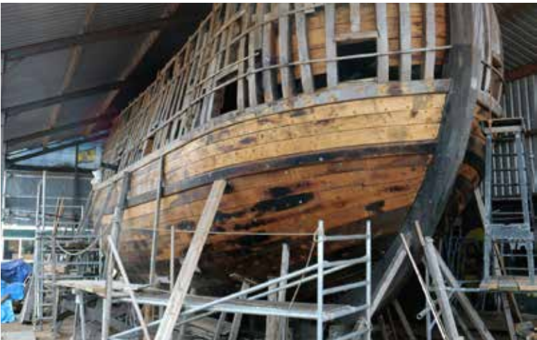
Na de plaatsing van de spanten werden daarop de huidgangen en berghouten van de hogere delen van de romp geplaatst. Destijds was dit het stadium waarin een schip te water werd gelaten. (Foto G. de Weerdt)
